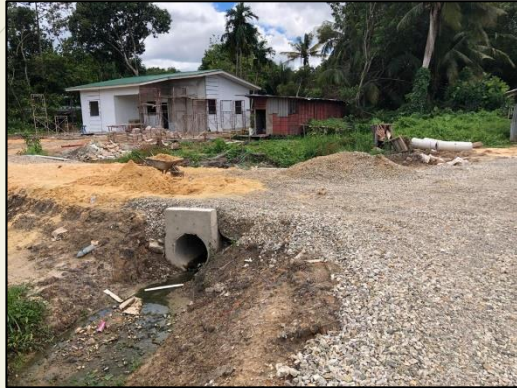
- Paras biduk longkang yang terlampau tinggi atau terlalu rendah
