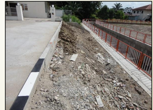
- Kemajuan tanah tanpa penyediaan Kawalan Hakisan Tanah ( Earth Control Measure )
