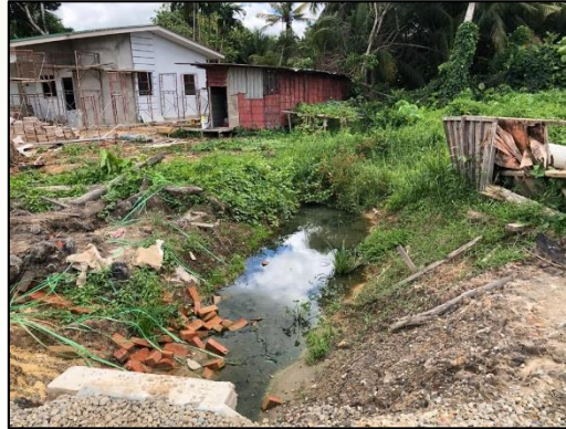
- Paras biduk longkang yang terlampau tinggi atau terlalu rendah
