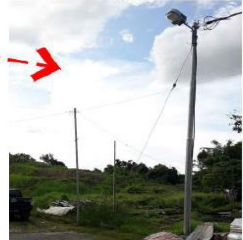
EXISTING TEL-BRU POLE
